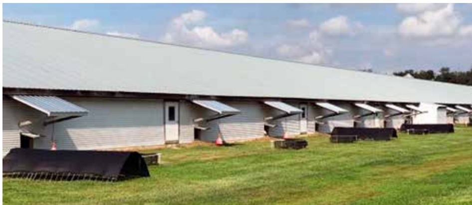
Farmen investeret i et nyt ventilationssystem, der tilbyder komplet luftskifte hvert 60. sekund. Foto: Charlotte Cunningham
