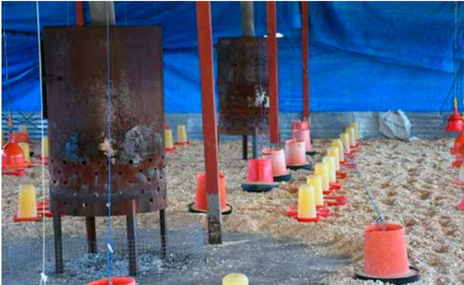
Kulbrændere bruges til at hæve staldenes temperaturer om vinteren. Foto: Chris McCullough
